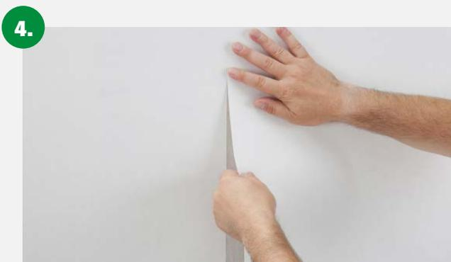
Die Folgebahn wird auf Stoß verklebt. Überstände zur Decke oder zum Boden mit einem Kunststoffspachtel andrücken und mit einem Cuttermesser beschneiden.
