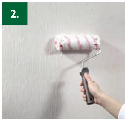
2. Glasgewebekleber oder geeigneten Vlieskleber auftragen.
