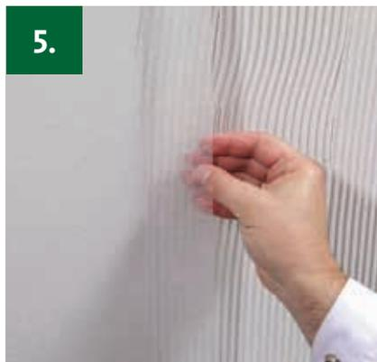
5. Die Folgebahn mit einer Überlappung von rund 5 cm anlegen, mittig leicht andrücken und ebenfalls bis ca. 5 cm zur Naht verpressen.
