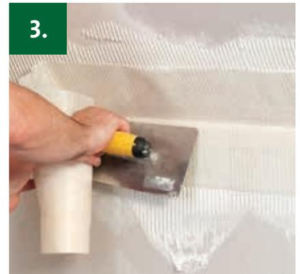
**3.** **KOBAU Armierungsecke** in die nasse Spachtelmasse einlegen und mit geeignetem Glättwerkzeug andrücken. Dabei die Zahnkellenstruktur vollständig unter dem Vlies zerquetschen.
