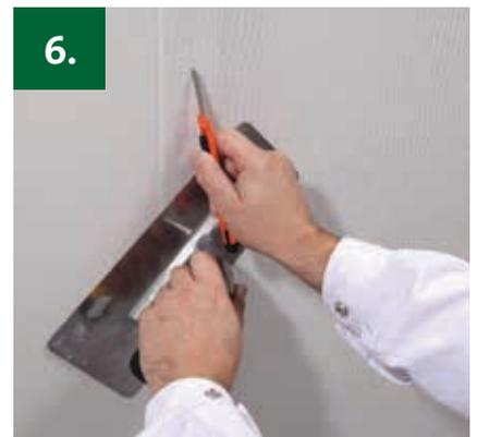
6. Doppelnachtschnitt mit dem Cuttermesser setzen und abgetrennte Vliesstreifen entfernen.
