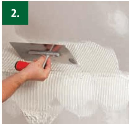
**2.** Nach der Trocknung **KOBAU Armierungsspachtel** satt auftragen und mit einer Zahnkelle 4 x 6 x 4 mm gleichmäßig durchkämmen.
