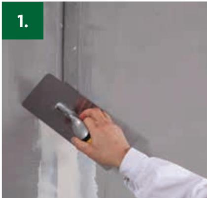
1. Die zu armierende Fuge wird nach VOB/C, DIN 18363 bzw. den relevanten BFS-Merkblättern vorbereitet und mit geeignetem Füllspachtel oberflächenbündig verfüllt.
