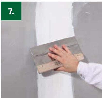
7. Anschließend mit einem Flächen- oder Gummirakel gemäß der Stärke des Gewebes wieder abziehen.
