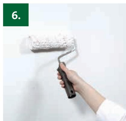
6. Die Zwischen- oder Schlussbeschichtung erst nach der Durchtrocknung nach mind. 12 Stunden auftragen.
