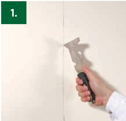
1. Den Einzelriss mit geeignetem Werkzeug aufweiten, entstauben und grundieren.
