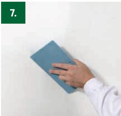
7. Anschließend abglätten, da an den entfernten Glasvliesstreifen zuviel Farbe haftet.
