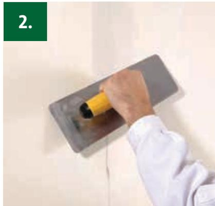
2. Nach der Trocknung geeigneten Füllspachtel oberflächenbündig auftragen, feinspachteln, schleifen und grundieren.
