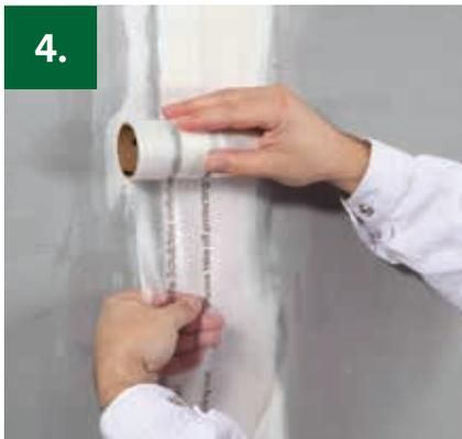
4. Das **KOBAN optitape SH** wird auf dem Fugenverlauf fixiert und die Folie auf der Rückseite entfernt.
