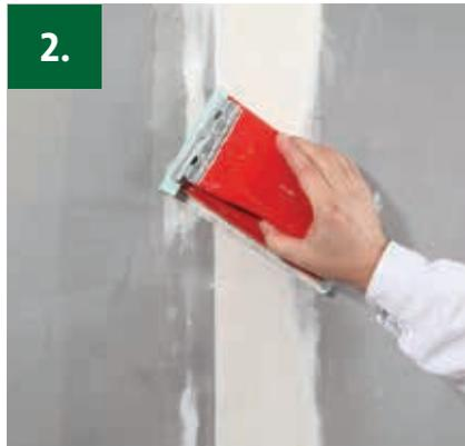
2. Nachdem die Feinspachtelung durchgetrocknet ist, wird der Fugenbereich geschliffen.
