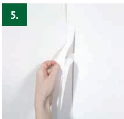
5. Ggf. Nahtschnitt ausführen und die Reststreifen entfernen. Im Nahtbereich heraustretenden Kleber mit einem feuchten Tuch abwischen.
