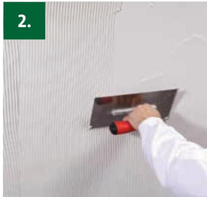
2. Anschließend die Spachtelmasse auf die Fläche auftragen und mit der Zahnkelle (4 x 6 x 4) durchkämmen.
