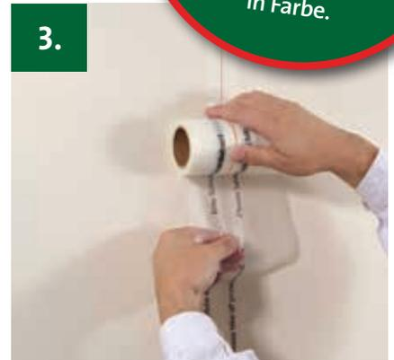
3. Das **KOBALU optitape SH** auf dem Rissverlauf fixieren und die Folie auf der Rückseite entfernen.
