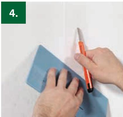
4. Anschluss der Vliesbahnen mit Doppelnachtschnitt herstellen und darauf achten, dass der Cutter nicht den Untergrund beschädigt.
