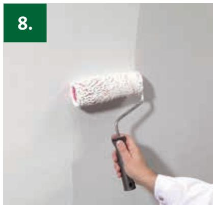
8. Nach vollständiger Durchtrocknung der Fläche eine pigmentierte, lösemittelfreie Grundierung auftragen.
