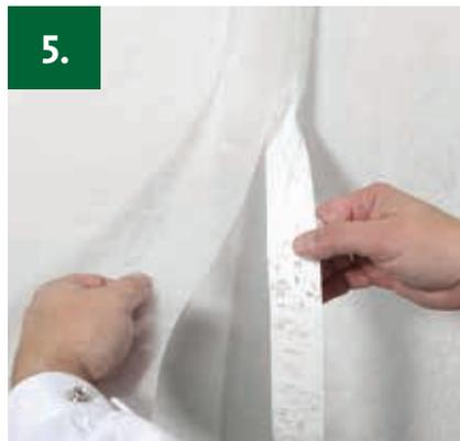
5. Die abgetrennten Kantenstreifen entfernen und den Nahtbereich mithilfe eines Kunststoffrakels schließen.
