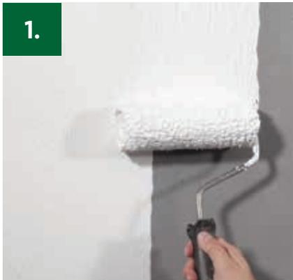
1. Dispersionsfarbe mit deutlicher Schlepstruktur satt auf den Untergrund auftragen.
