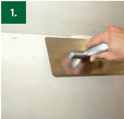
**1.** **KOBAU Armierungsspachtel** und Quarzsand im Verhältnis 1:3 mischen und damit die Fugen verfüllen, ggf. Hinterfüllschnur einlegen.
