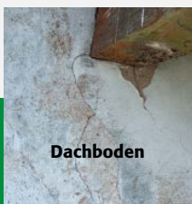
Streichfüller mit Putzoberflächenrissen
